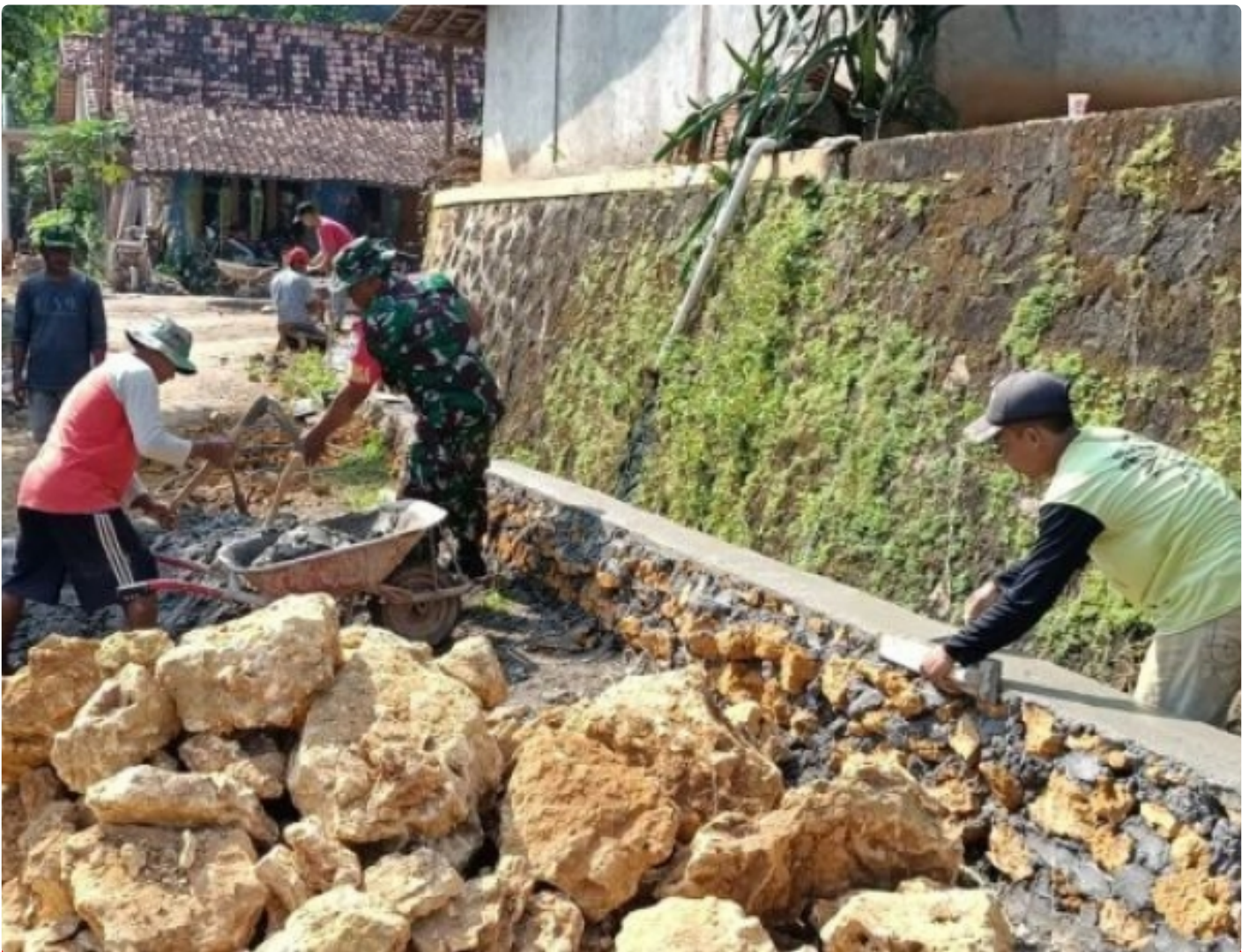
Babinsa Koramil 14/Todanan Serma Juwanto bersama warga binaan ikut membangun talud di desa Cokrowati, Kecamatan Todanan
