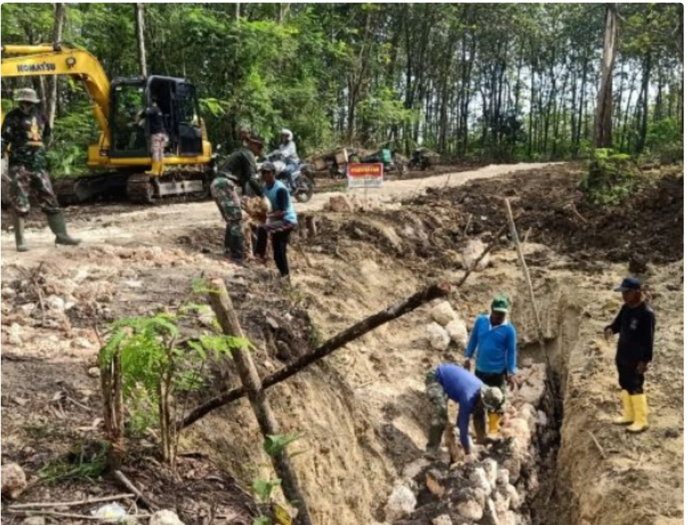
Satgas TMMD bersama dengan warga dalam pembangunan talud di lokasi TMMD reg ke-113
