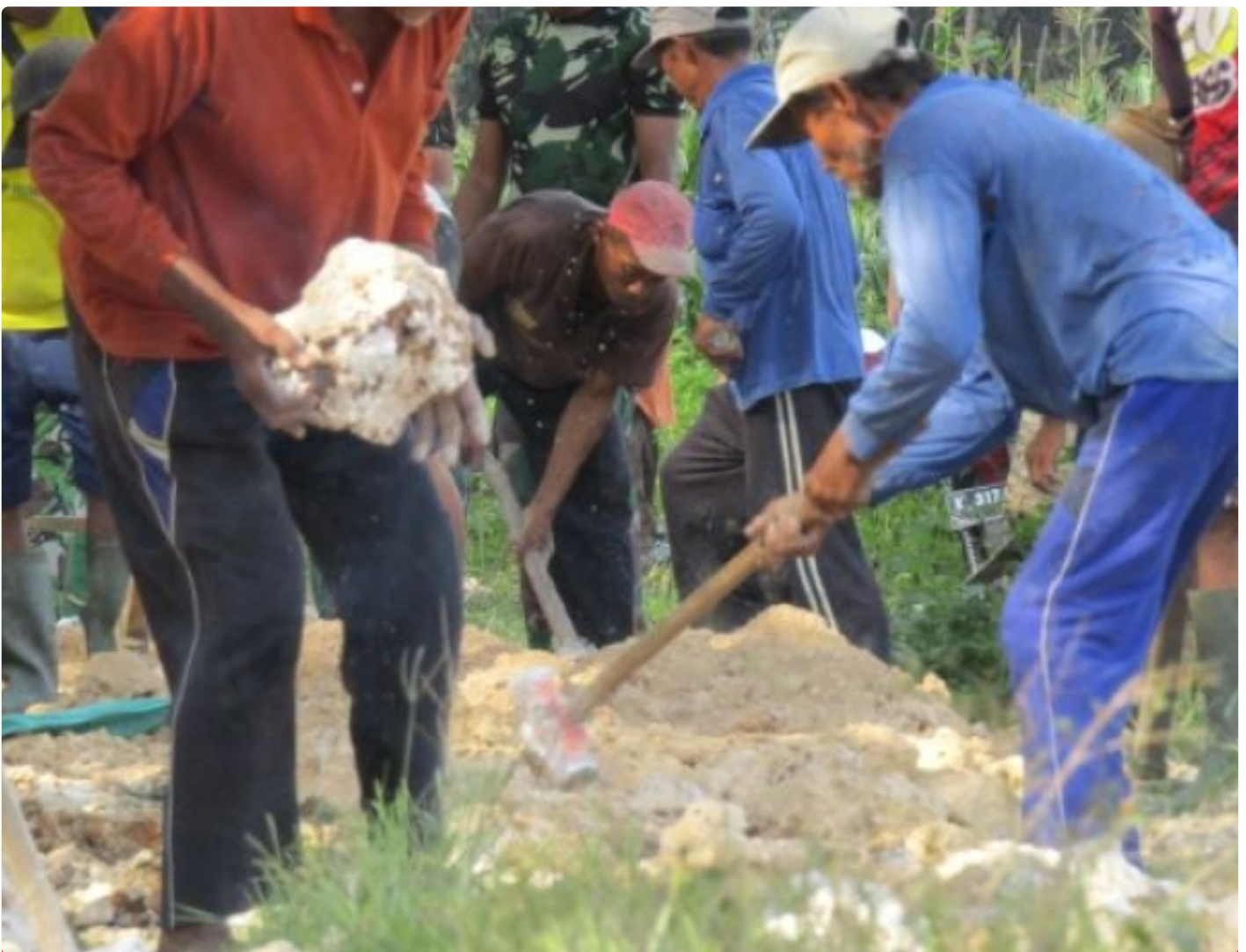
Satgas TMMD bersama dengan warga dalam pembangunan ruas jalan di lokasi TMMD reg ke-113
