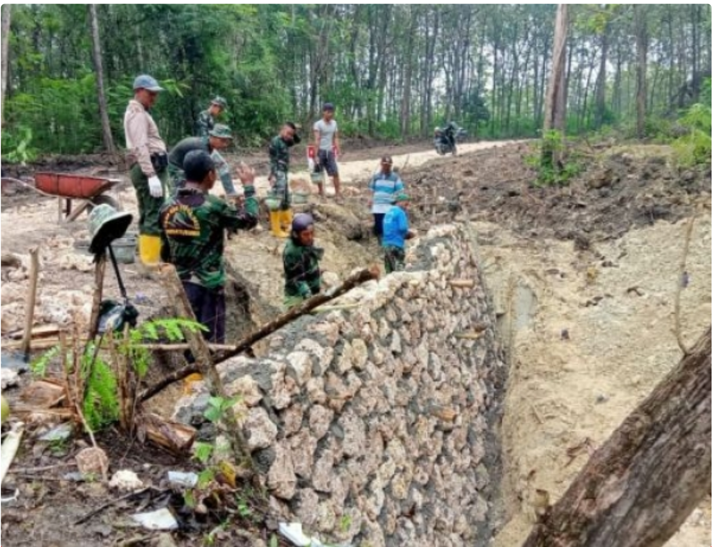
Satgas TMMD Reguler ke-113 Kodim 0721/Blora bersama warga langsung kebut pembangunan talud di Desa Pengkoljagong
